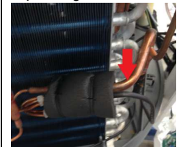
Hőelem pozíciója Elpárologtató érzékelő
